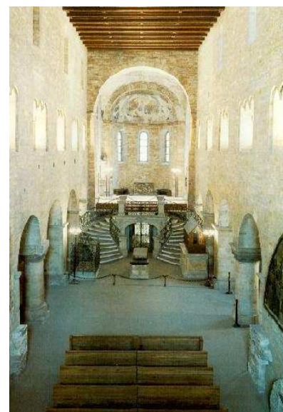
Oporou stavby jsou silné opěrné sloupky uvnitř stavby. Zdivo je hrubé a neomítané.
